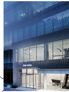
資生堂 本店(銀座オフィス) Shiseido Head Office (Ginza Office)
